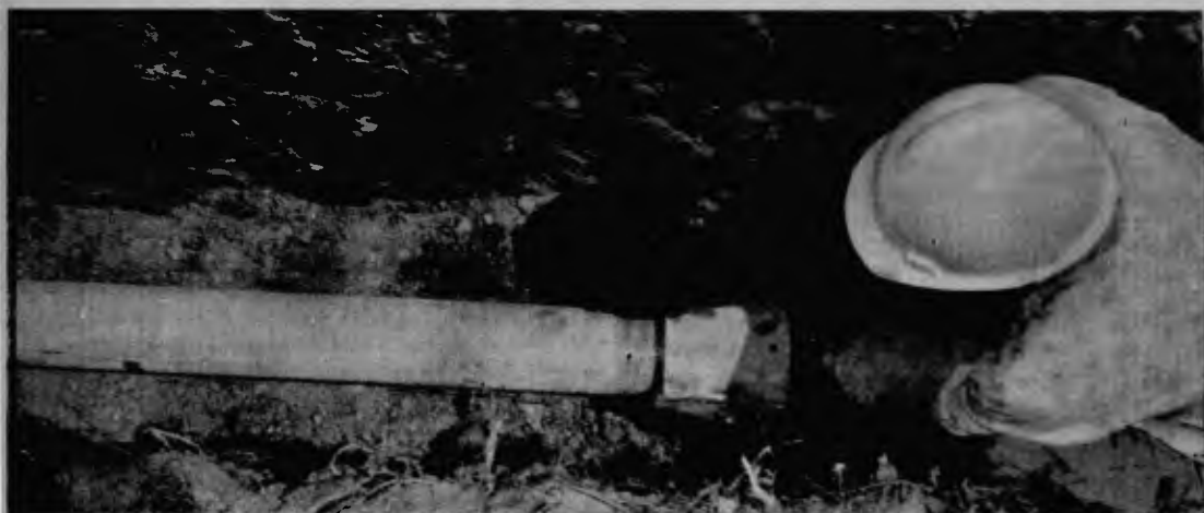
Para la conducción del agua se utilizan, en el interior del país, tubos de asbesto, y para la capital, de hierro. Los primeros se adquieren en Colombia, en Europa y en los Estados Unidos de América. En la foto, un obrero pone una tubería.
