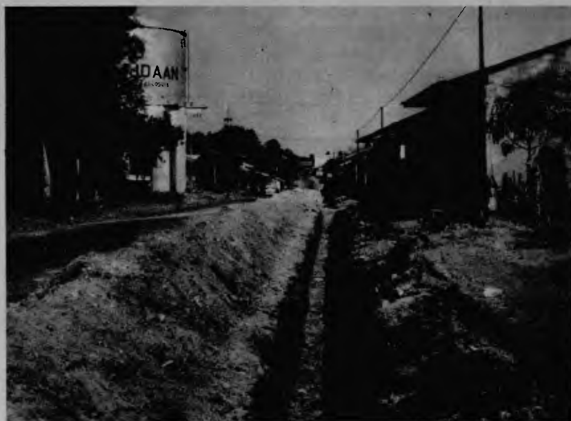
En la localidad de Aguadulce, provincia de Coclé, a la izquierda, el tanque del IDAAN, y en el centro de la calzada, que no es la más importante, la zanja para la tubería.
