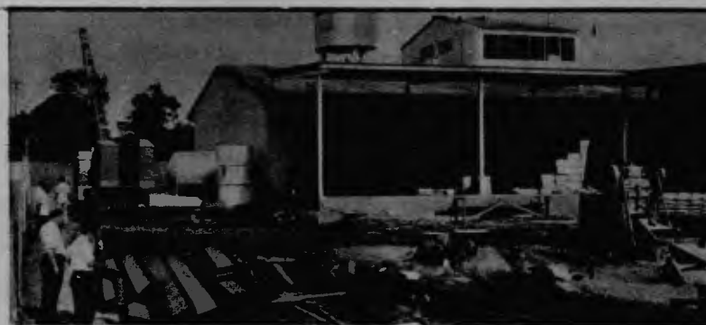
La lente de FELIX GAITAN capta esta vista de un grupo de trabajadores Chiricanos contratados por Ingenieria Amado cuando realizan trabajos estructurales y de colocación de material aislante para los nuevos cuartos fríos de la Cervecería del Barú. Estos cuartos, completamente forrados con 8 pulgadas de corcho, permiten a la empresa sostener una temperatura constante de 0° centígrados a través de todo el proceso de maduración de la Cerveza Panamá.
