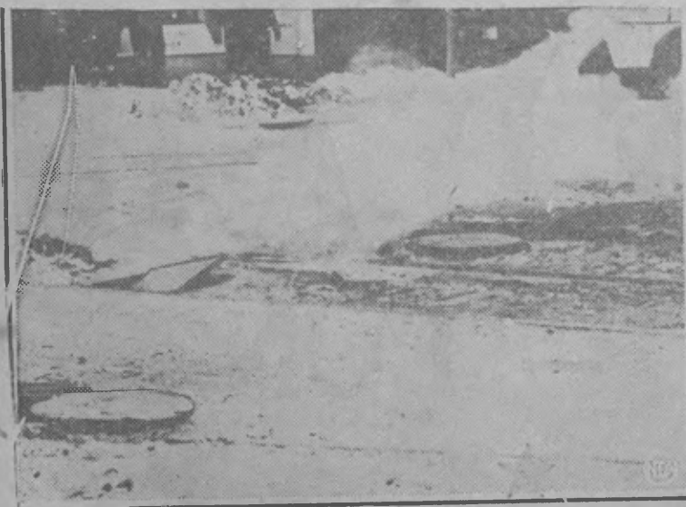
GASES VENENOSOS escapados de las cloacas y explosiones terribles llenaron de pánico a la pequeña ciudad de Utica, N. Y., E.E. UU. La acumulación de gas en los recodos de las cañerías produjo rupturas en las mismas y explosiones en las aperturas de inspección cuyas tapas volaban violentamente. Algunos obreros y guardias sufrieron envenenamiento y heridas. Se ve en la foto a uno de los últimos a quien se prestan auxilios de emergencia.
