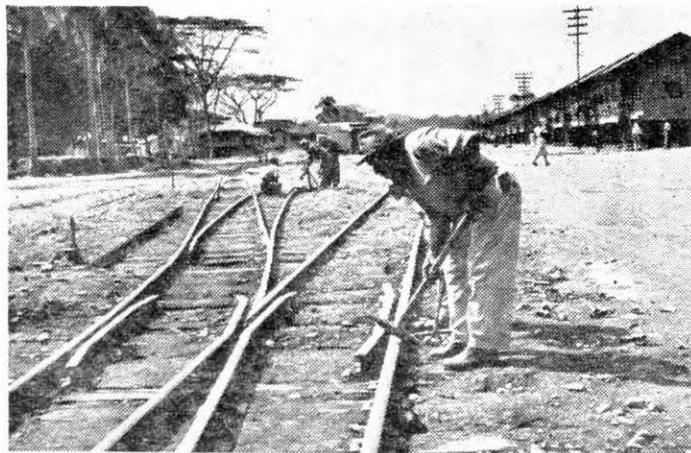
Se trabaja arduosamente en el tendido de nuevas líneas férreas en diversas fincas y poblaciones bananeras.
