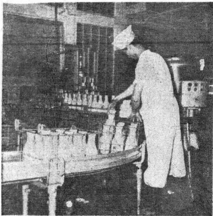
... Máquina moderna que llena automáticamente setenta y dos unidades por minuto...
