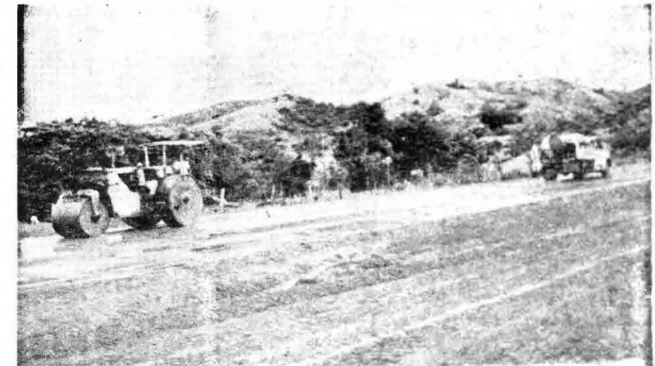
La carretera central de Pesé, fue construida con imprimación asfáltica, teniendo un largo de 20 kilómetros. Un total de 160 kilómetros de este tipo de carretera asfáltica, ha sido construida en el primer año de administración del Presidente Robles y el Ingeniero Bazán, en la CAM.
