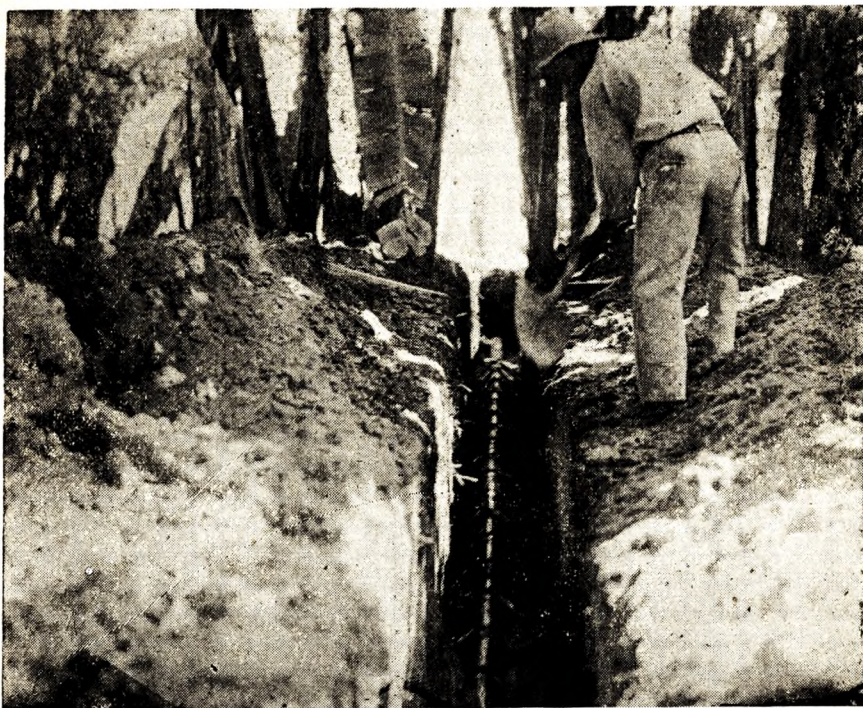
Un ramal del sistema de Alcantarillado en Penonomé.
