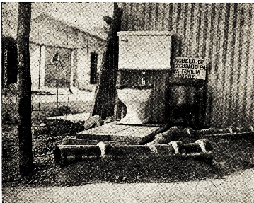
Un inodoro moderno y el servicio sanitario económico, recomendado para las familias pobres en las poblaciones donde el Departamento está construyendo sistemas de alcantarillado.
