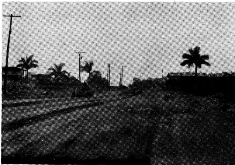
Ensanche, nivelación y compactación de la Avenida Federico Boyd.
