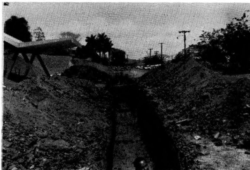
Excavando zanjas para el alcantarillado frente al edificio del Ateneo de Ciencias y Artes.
